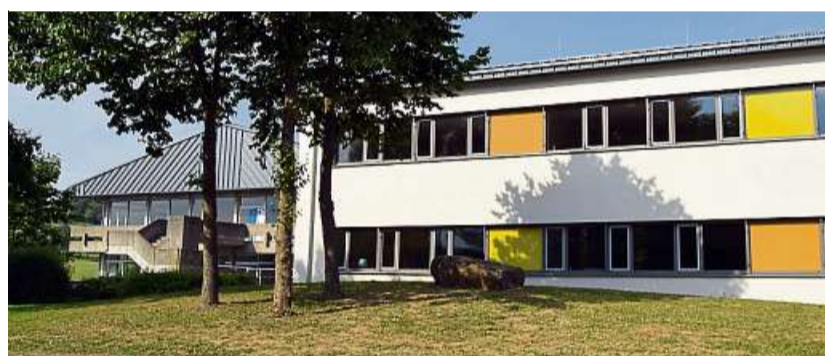
Der Erweiterungsbau an der Vogelsbergschule ist fertiggestellt und schon in Betrieb. Am Hauptgebäude (links im Hintergrund) beginnen die Sanierungsarbeiten in den Sommerferien. Foto: Weil
